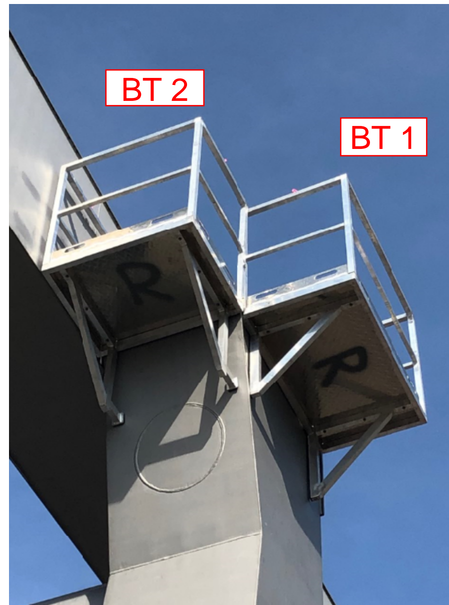
Eingehängte Bühnenteile am rechten Pylon
